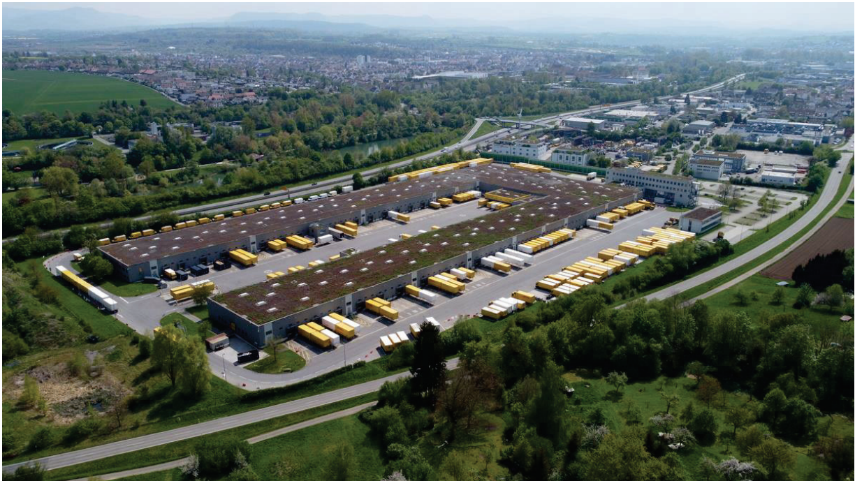
Abb. 1: Bestandsgebäude des Paketzentrums; Blickrichtung Südosten, (29.04.2022).
