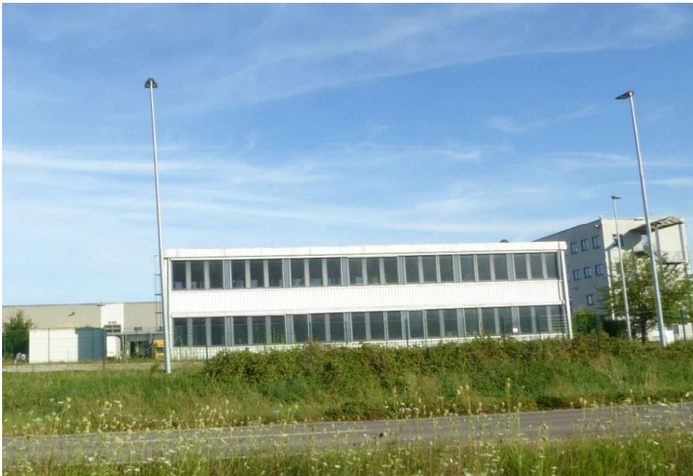
Abbildung 2. Mastleuchten im Bestand, Foto Müller-BBM Industry Solutions GmbH.
