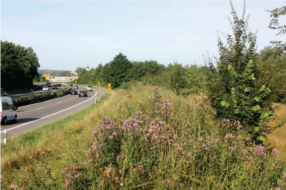
Abb. 13: Lärmschutzwall entlang der B313.
